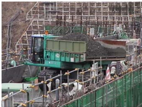
写真-2 くるくるダンプにより運搬
