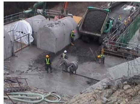
写真-3 堤体頂部施工状況
