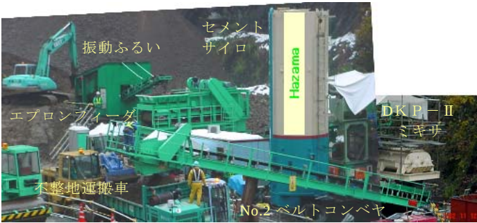
写真－3 施工状況
