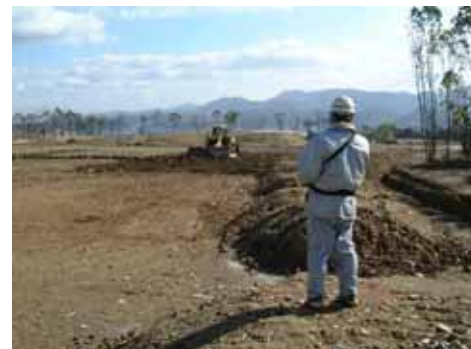
写真-2 作業性確認試験状況 (遠隔操作距離 40m)
