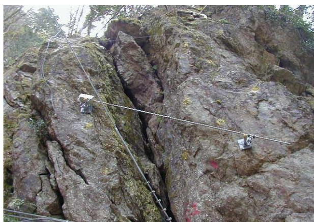
図1. FBG式岩盤亀裂計の設置状況
