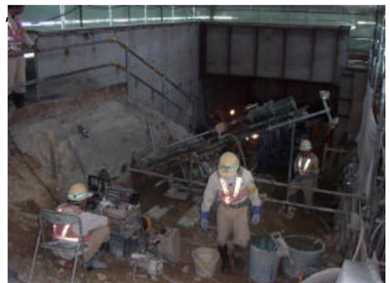
写真-1 ラディッシュアンカー施工状況
