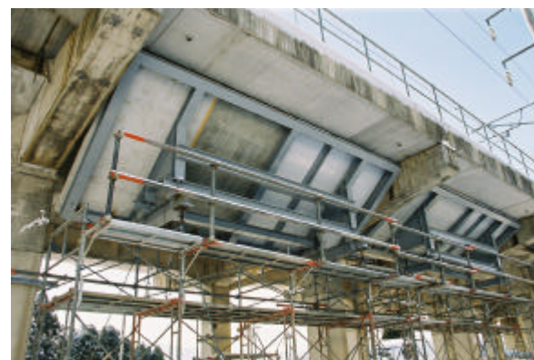
図-2 試験体（下側防音壁）設置状況
