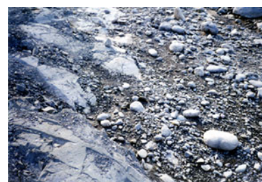
写真-3. 施工直後の河床状況
