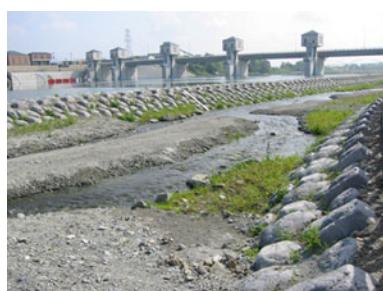
写真-4. 完成の魚道全景
