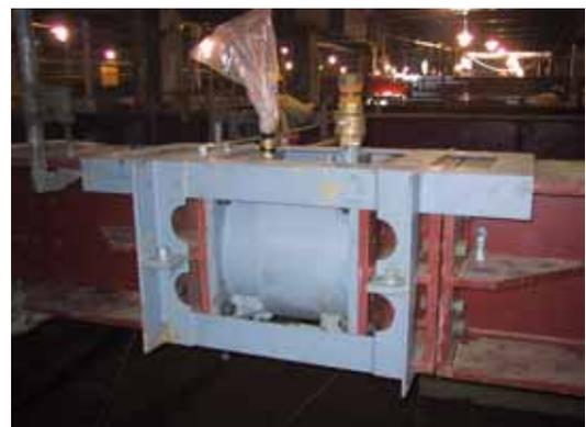
写真 - 4.1 切梁ジャッキ架設状況
