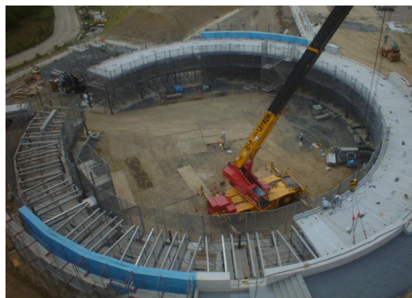
写真-1 PCa版設置状況
