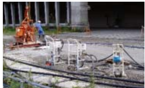
写真 - 1 現場実証実験状況
