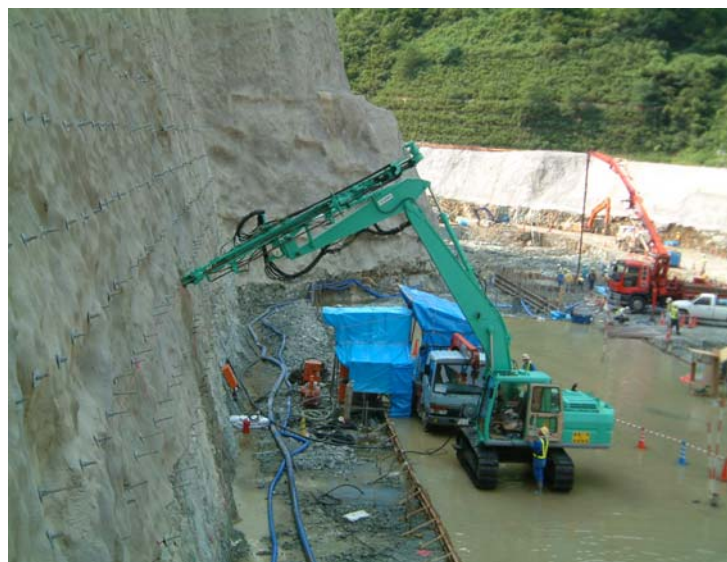
写真-1.1 高所ボーリングマシン施工状況
