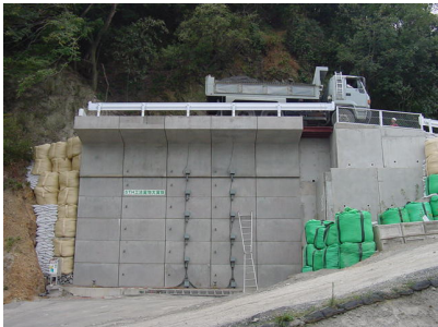
図-3 載荷実験状況
