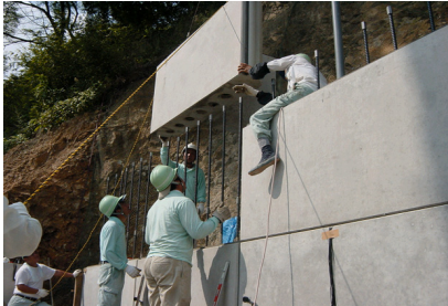
図-2 施工実験状況
