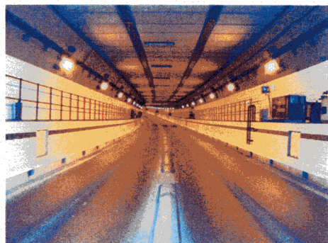
写真－2 改修工事後トンネル状況
