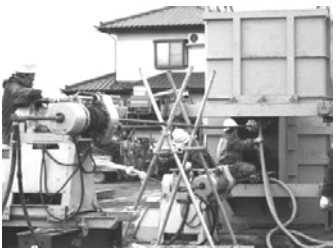
写真 - 3 切削・押し込み実験
