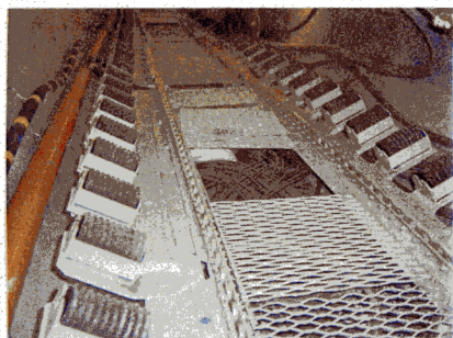
写真-2 電線台車
