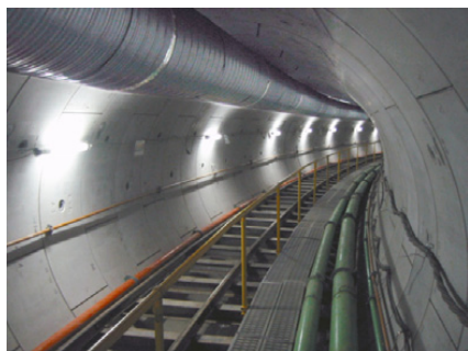
写真-1 仕上がり状況
