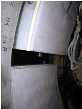
写真－3 セグメント組立状況
