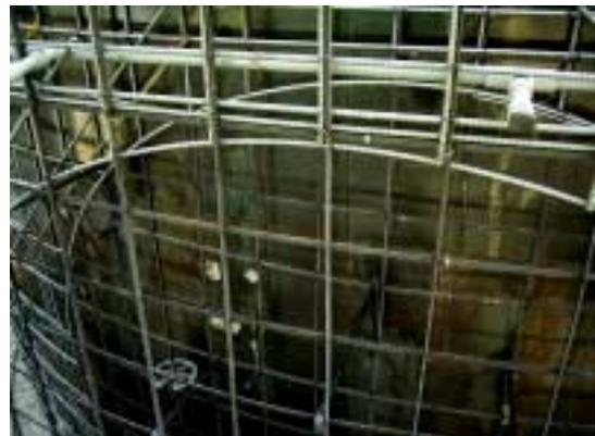
写真-1 鏡切部の配筋状況
