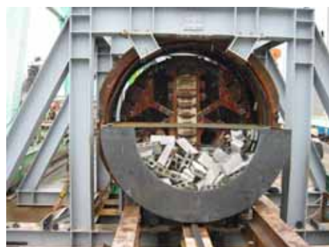
写真-2 コンクリート塊回収後状況
