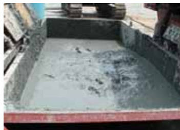
写真 3 処理前掘削土
