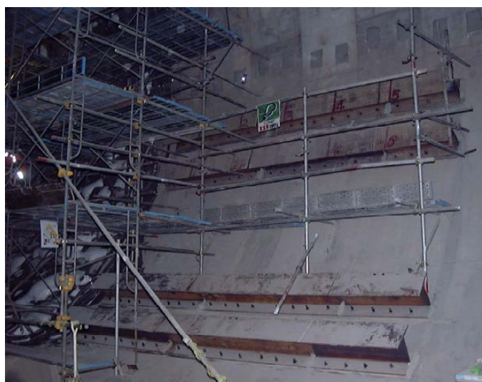
写真-1 RC セグメント補強工
