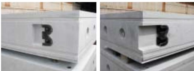
A-A継手 B-K間継手
