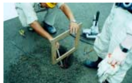
写真-2 熱電対の埋設作業
