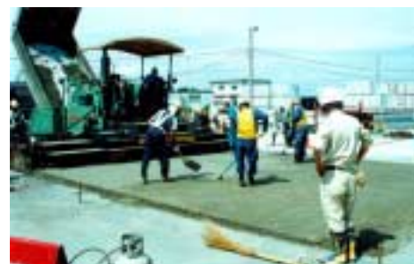
写真-1 試験区の転圧舗装状況
