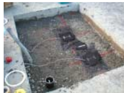
写-1 ひずみ計設置状況
