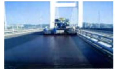
図 2 マイクロサーフェッシングの施工状況（下津井瀬戸大橋）
