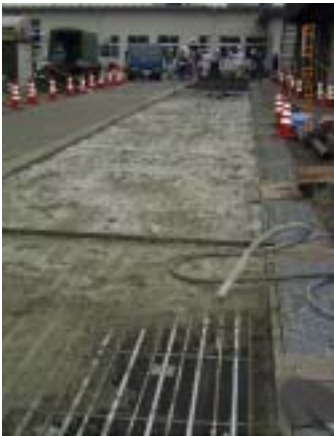
写真-1 施工状況
