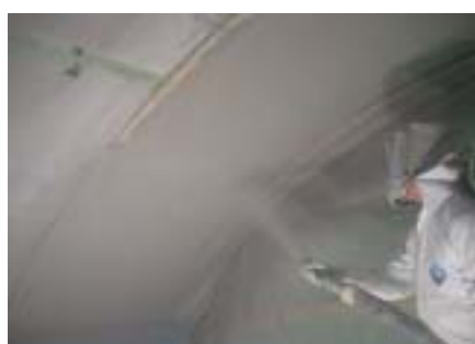
図-2 乾式吹付け工法
