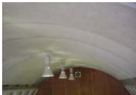
図-1 擬似トンネルへの施工
