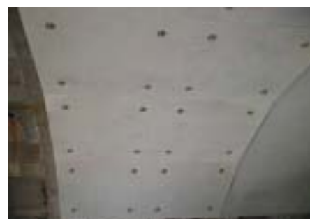
図-3 パネル貼付け工法
