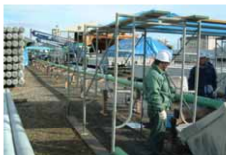
写真-1 ポンプ圧送の状況
