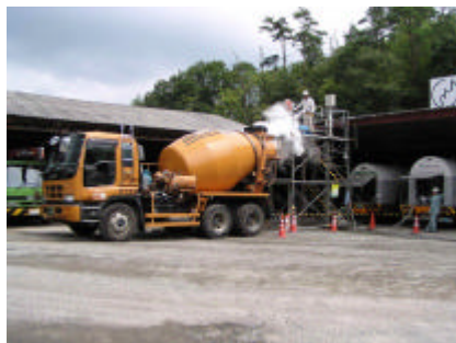
写真-1 コンクリート冷却状況
