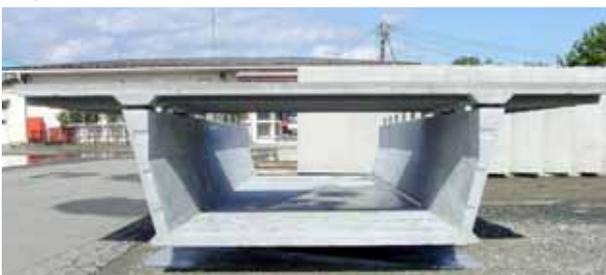
写真.1 桁断面
