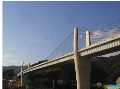
写真-1 完成した日見夢大橋
