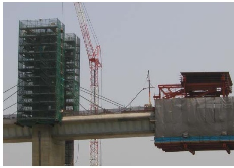
写真-3 斜材架設状況
