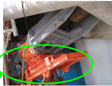
写真-4 斜材緊張状況
