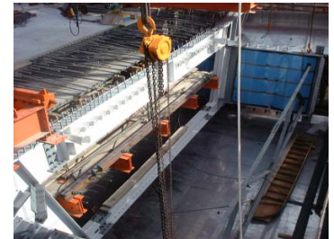
写真-6 波形架設完了
