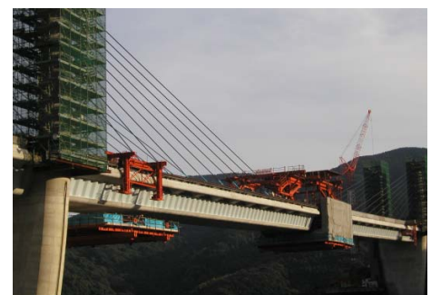
写真-9 ワーゲン作業台後退状況
