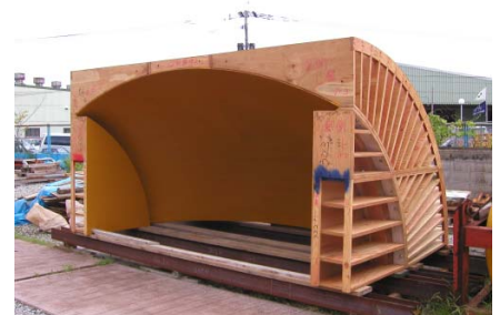
写真-8 主塔頂部型枠
