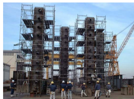
写真-2 鋼殻仮組立状況
