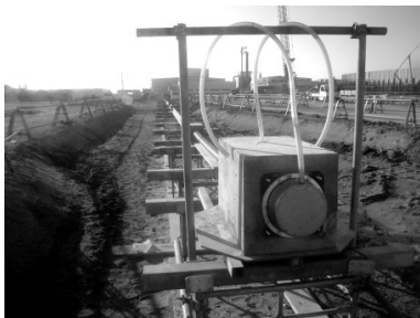
写真-1 実大モデル試験体全景
