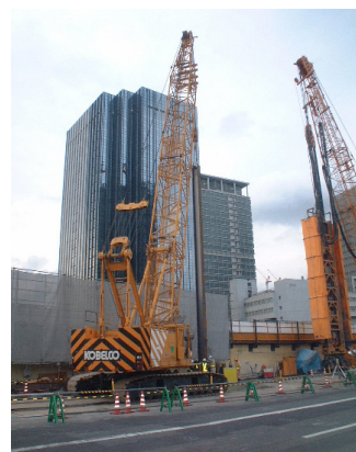
図-4 施工実証工事 芯材建込み状況
