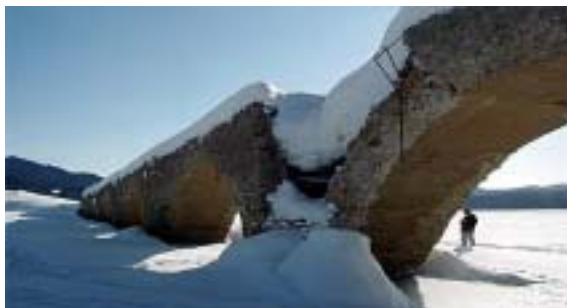
写真 3-1 地震による崩壊 東大雪アーチ橋の会提供
