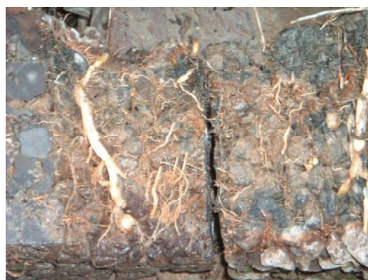
写真1 ポーラスコンクリート供試体中へのヨシの根の伸長状況
