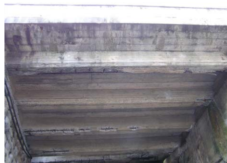
写真-1 橋梁上部工下面の状況
