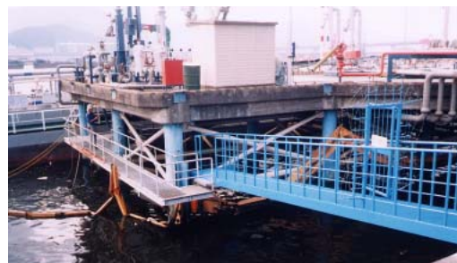
写真-1 対象栈橋の全景写真
