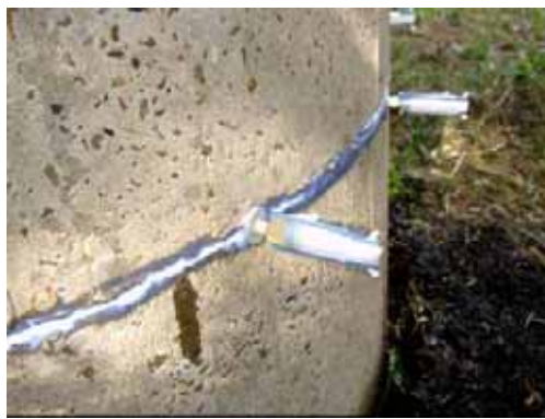
図2 P3橋脚打継部の補修状況
