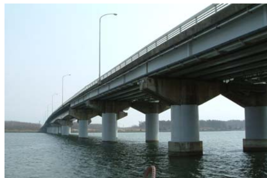
写真-1 施工前全景
