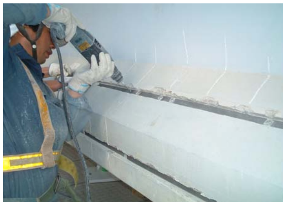
写真-3 陽極の設置
