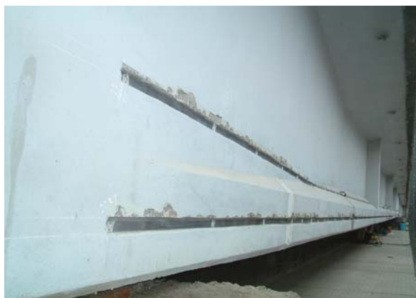
写真-2 陽極の設置
