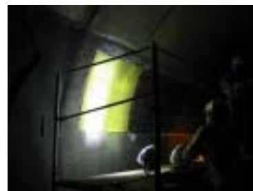
写真⑤ シート貼付け後、光照射
