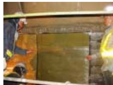
写真⑥ 表面フィルム剥し
