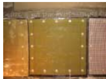
写真⑧ アラミド®一体型シート完了
