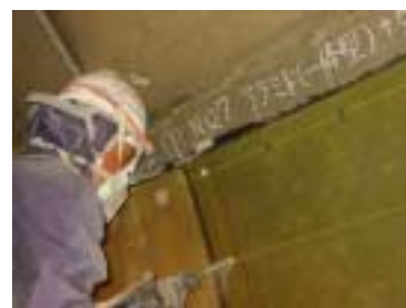
写真⑦ アラミド®ネイル削孔
