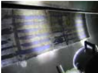
写真③ 不陸修正後、光照射
