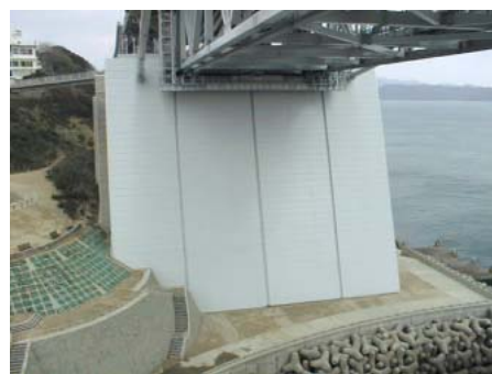
写真-1 表面被覆工の樹脂系塗装施工例
