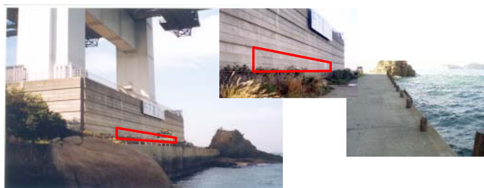
写真－2 下津井瀬戸大橋3P 試験位置（□内）
