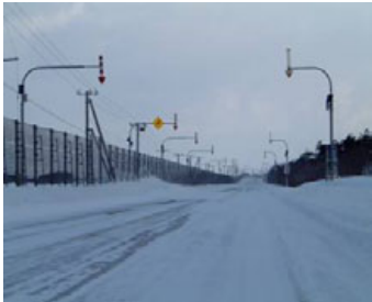
写真 2 "矢羽根" の設置状況
