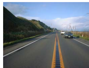
写真-1. 国道に設置されたランブルストリップス
