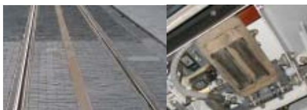
写真4 軌道(左)と車両床下の集電装置(右)
