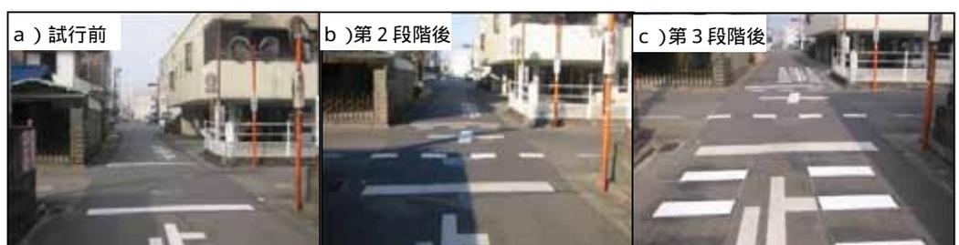
図-8 交差点明示と一時停止標示改良
