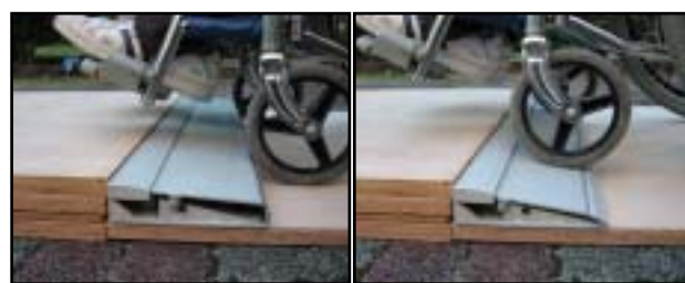
(a) 原型 (b) 車椅子昇降時 写真-2 可動式縁石
