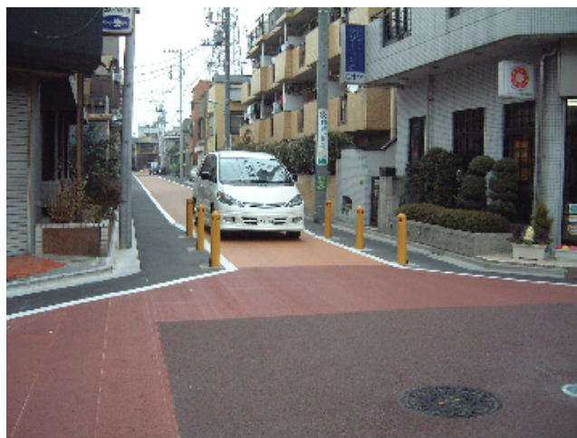
図1 設置した狭さくの状況
