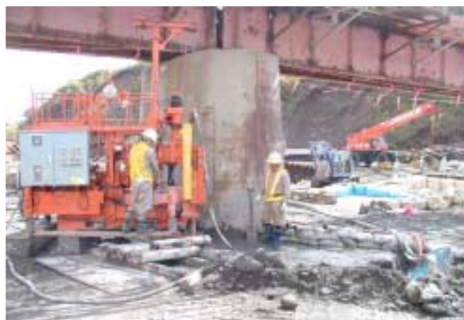
図-1 高圧攪拌混合による地盤改良
