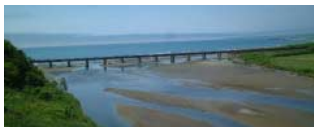
図-2 厚別川橋りょう全景
