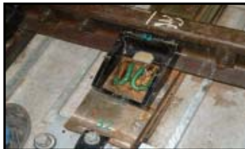
写真-1. ファーストクリップ型分岐器締結装置
