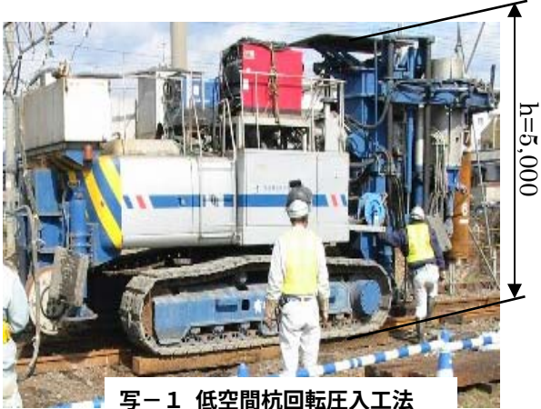
写-1 低空間杭回転圧入工法
